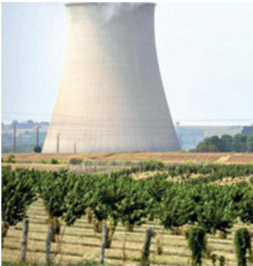
Le torri di raffreddamento di una centrale
