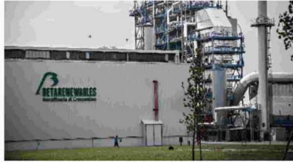
IL PRIMO IMPIANTO AL MONDO PER LA PRODUZIONE DI BIOCARBURANTI DI SECONDA GENERAZIONE, NEL VICENTINO. SOTTO: IL PARCO EOLICO DI CAPRACOTTA
